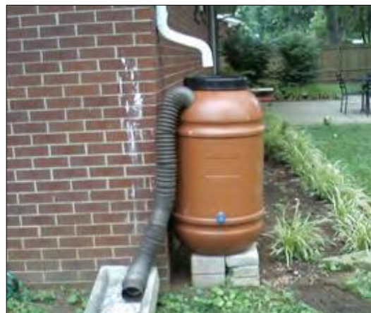
Figura 20: Una botte per lo stoccaggio domestico dell'acqua piovana (Fonte: EPA).
