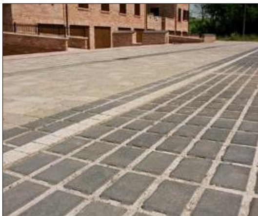
Figura 19: Una pavimentazione drenante (Fonte: Masulli).
