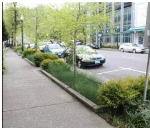
Figura 18: Un'aiuola d'infiltrazione (Fonte: EPA).
