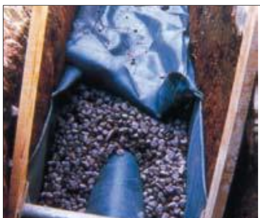
Figura 21: Una trincea d'infiltrazione (Fonte: EPA).
