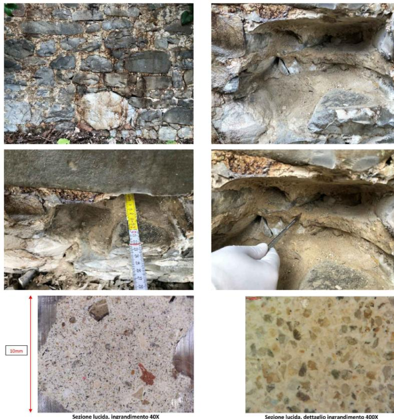
Al fine di prelevare un campione di malta sono stati rimossi alcuni conci in pietra del paramento esterno. La struttura esterna risulta perfettamente stabile ed ancorata; la malta dei giunti è tenace e di buona composizione. I prelievi sono stati effettuati a profondità differenti: il campione per l'analisi petrografica è stato prelevato alla profondità di 12cm, mentre quello per la datazione al carbonio 14 è stato prelevato a profondità 22cm.
